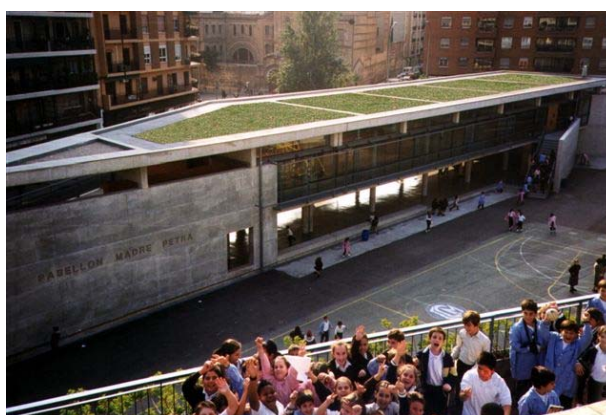
Figura XX. Cubierta Vegetada en Colegio (Valencia).
