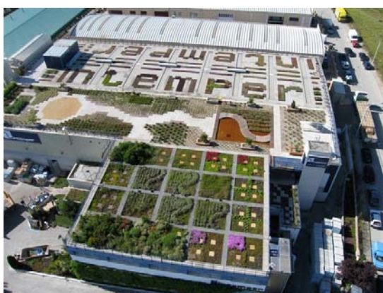
Figura 11 Cubierta Experimental Intemper (Madrid).
