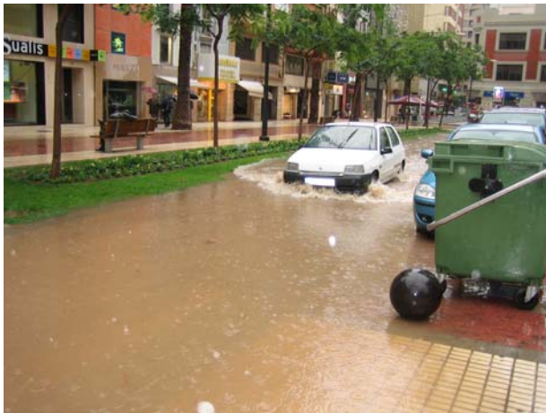
Figura 01. Av Rey D. Jaime I (Centro de Castellón, España). Red de colectores subterránea sobrecargada. El agua circula por superficie, por zonas no destinadas para ello.
